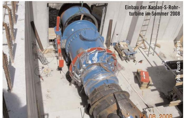
Einbau der Kaplan-S-Rohrturbine im Sommer 2008
