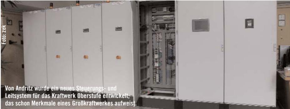
Von Andritz wurde ein neues Steuerungs- und Leitsystem für das Kraftwerk Oberstufe entwickelt, das schon Merkmale eines Großkraftwerkes aufweist.
